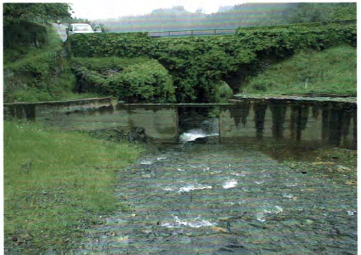
FOTO 7. Passagem pedonal a revestir de madeira
