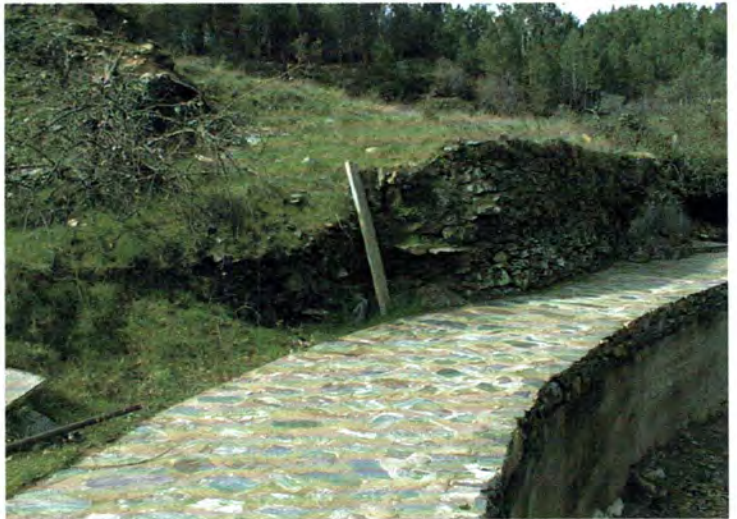
FOTO 6. Muro de pedra a recuperar
