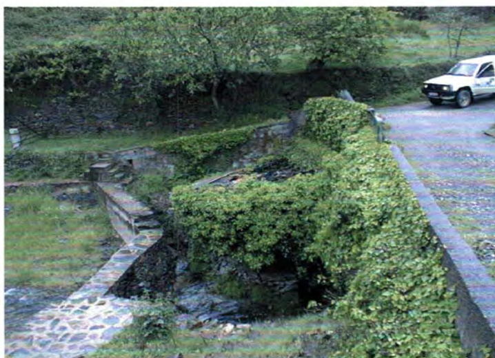
FOTO 4. Vista sobre o moinho de rodízio em ruína
